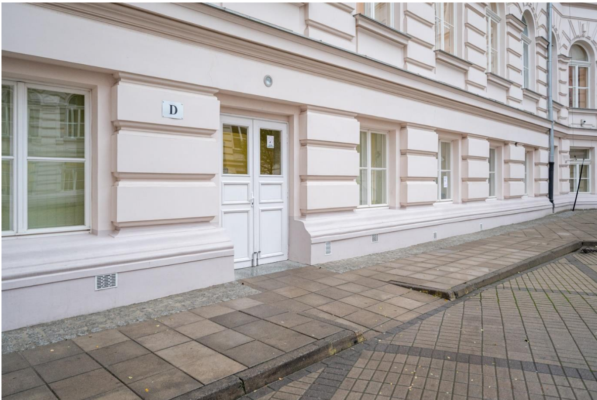
Zdjęcie 18 Widok na drzwi wejściowe z pochylnią, klatka schodowa "D"
