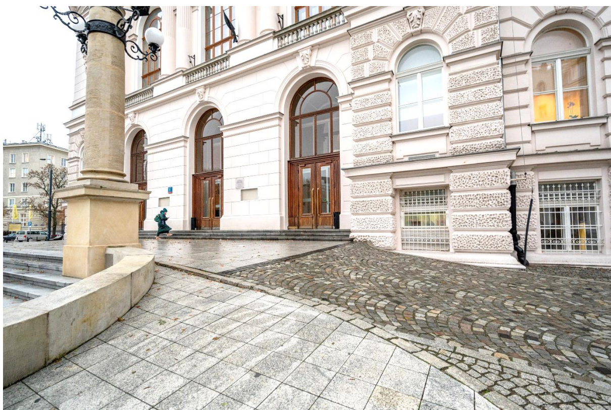
Zdjęcie 8 Widok na wejście główne. Wjazd dla samochodów na górny poziom placu.
