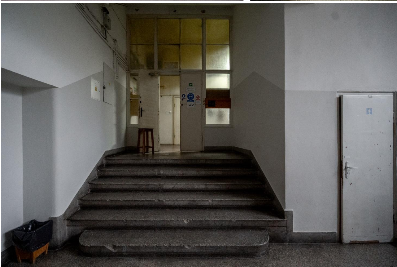
Zdjęcie 17 Widok na korytarz zakończony schodami na parterze oraz na półpiętro II-piętrze w obrębie klatki schodowej (K3).
